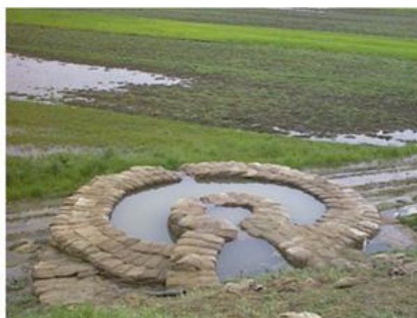
5. sz. képcsoportok: A buzgár kiépített ellennyomó medencéje
