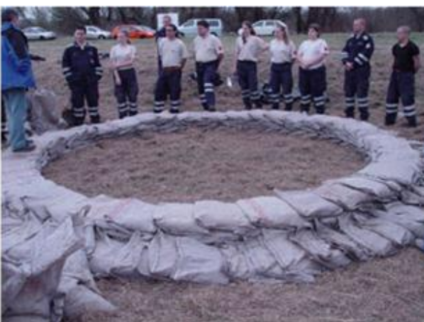
6. sz. képcsoportok: A buzgár ellennyomó medencéjének kiépítése
